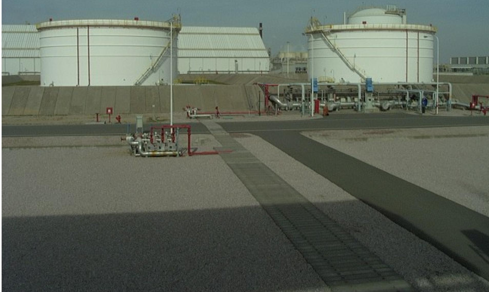
Hay 2 tanques, uno recibe producción mientras que el otro es destinado a despacho. Los tanques son de 15.000 m<sup>3</sup> cada uno y techo flotante. Volúmen total despachable 23.000 m<sup>3</sup>. Del tanque destinado a despacho se procede a extraer 12 muestras de 1 litro c/u, destinadas a determinar la calidad de la gasolina, y otras para conservar en guarda, tanto en Mega como en la Cía de Control.
