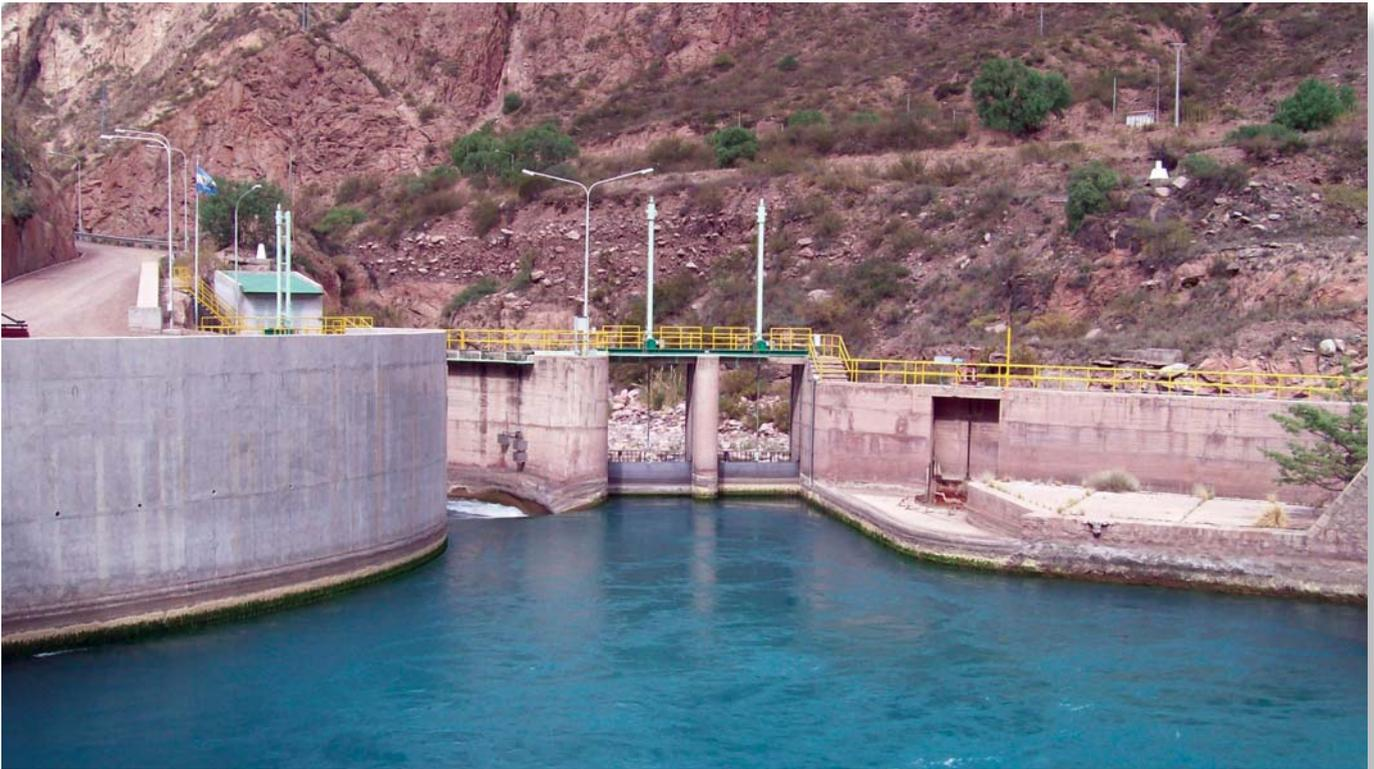
Vista desde la dársena de restitución de la central Cacheuta. A la izquierda se aprecia el inicio de la conducción a la central A. Condarco y a la derecha la restitución al río.
