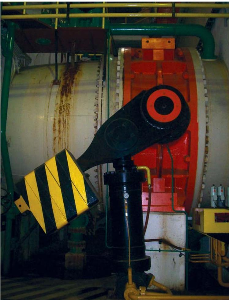
Vista de la válvula mariposa de cierre de la conducción de alimentación de la cámara espiral, con su contrapeso y sistema de accionamiento hidráulico.
