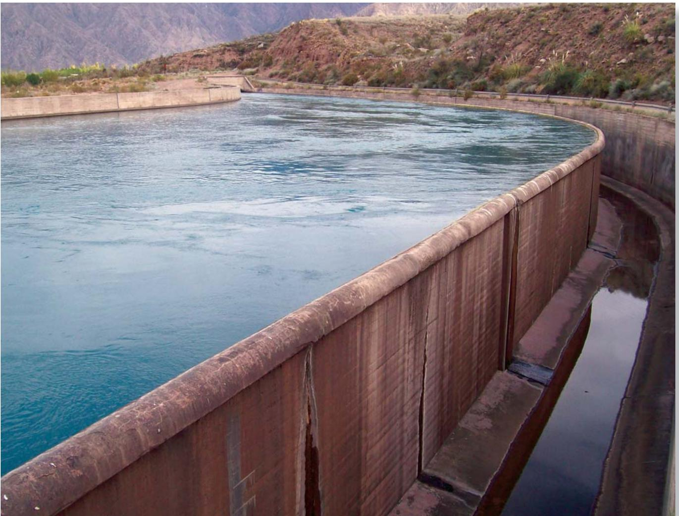
Vista de detalle del vertedero lateral que regula el nivel de la cámara de carga.
