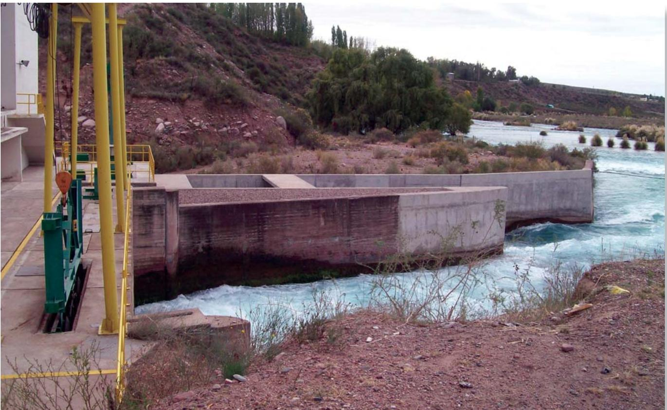
Vista del canal de restitución, se aprecia una de las compuertas que sirven como ataguías del mismo y su mecanismo de accionamiento.
