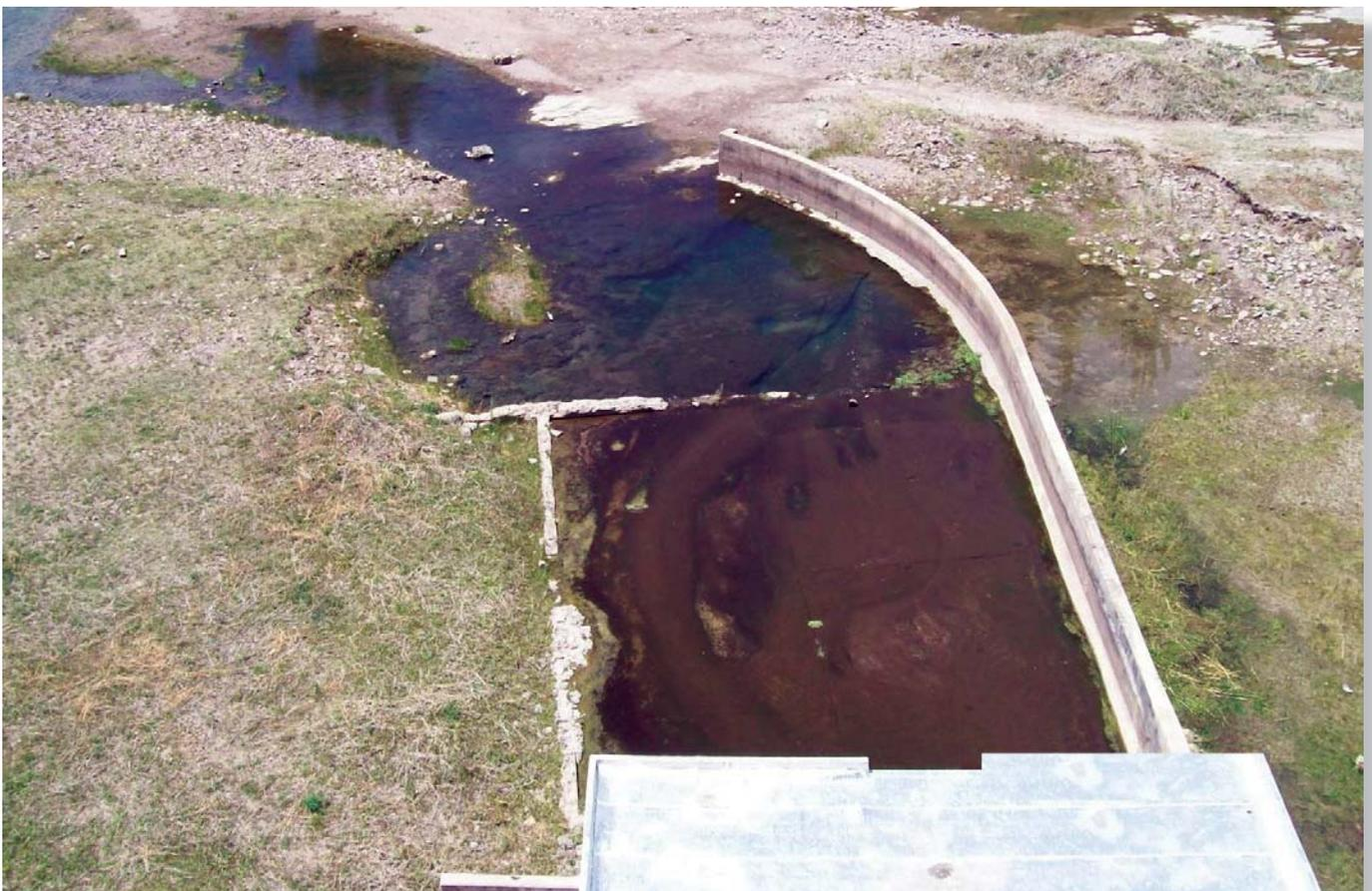
Vista desde el coronamiento de la presa, del canal de salida del descargador de fondo.
