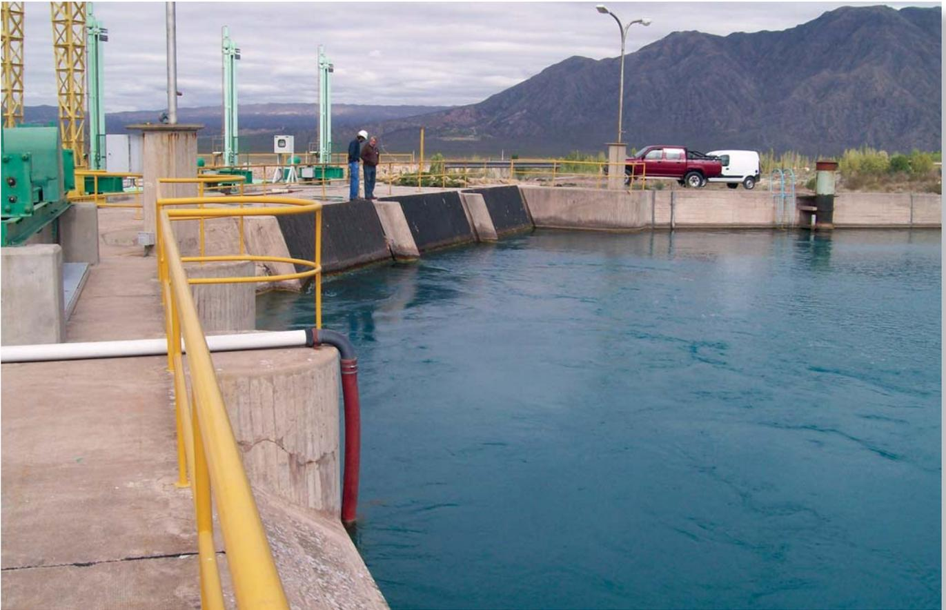
Vista de las rejas y de los sistemas de accionamiento de las tres válvulas mariposa de los conductos.
