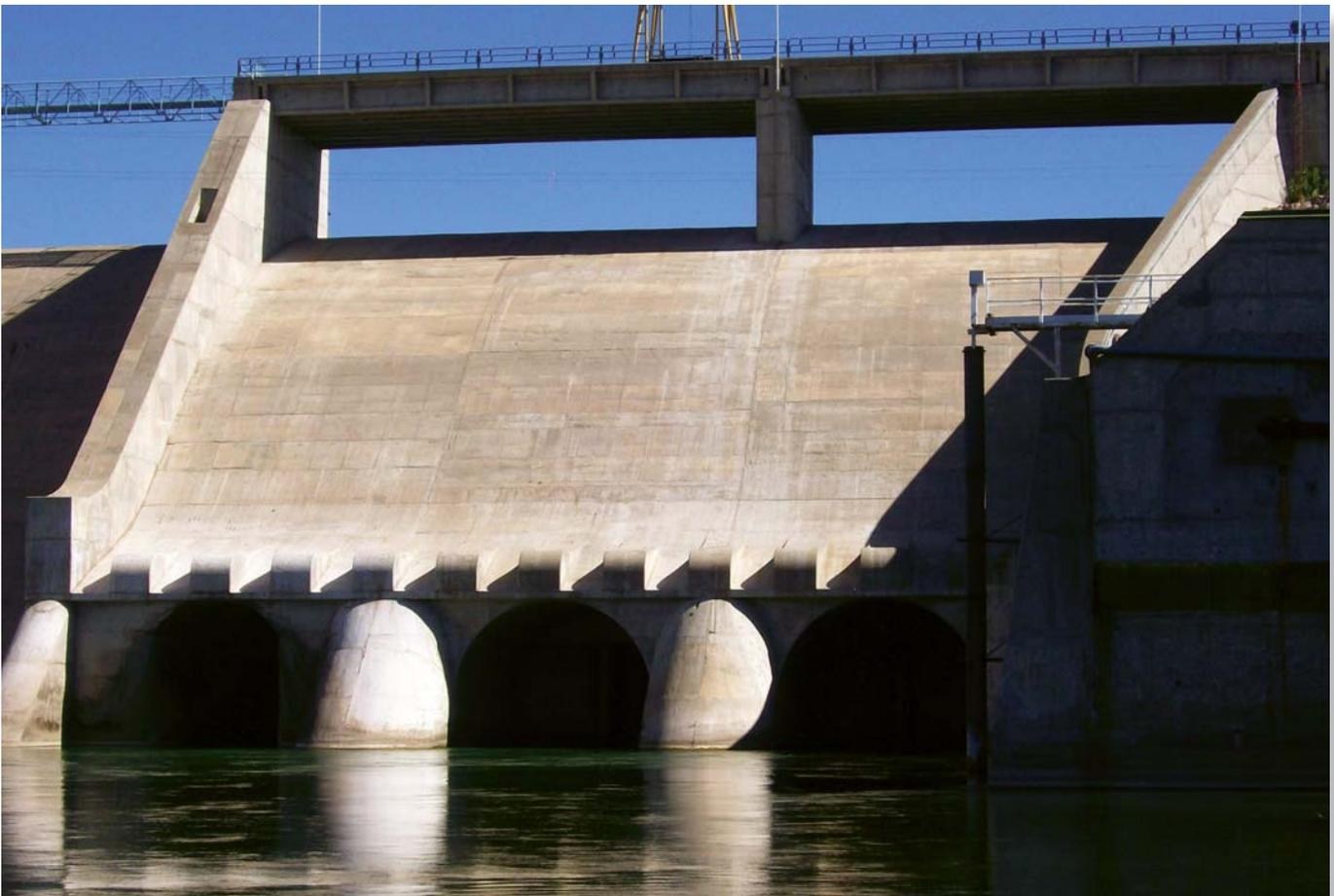
Vista de detalle del sistema de disipación de energía del aliviadero sobre tramo de la central.
