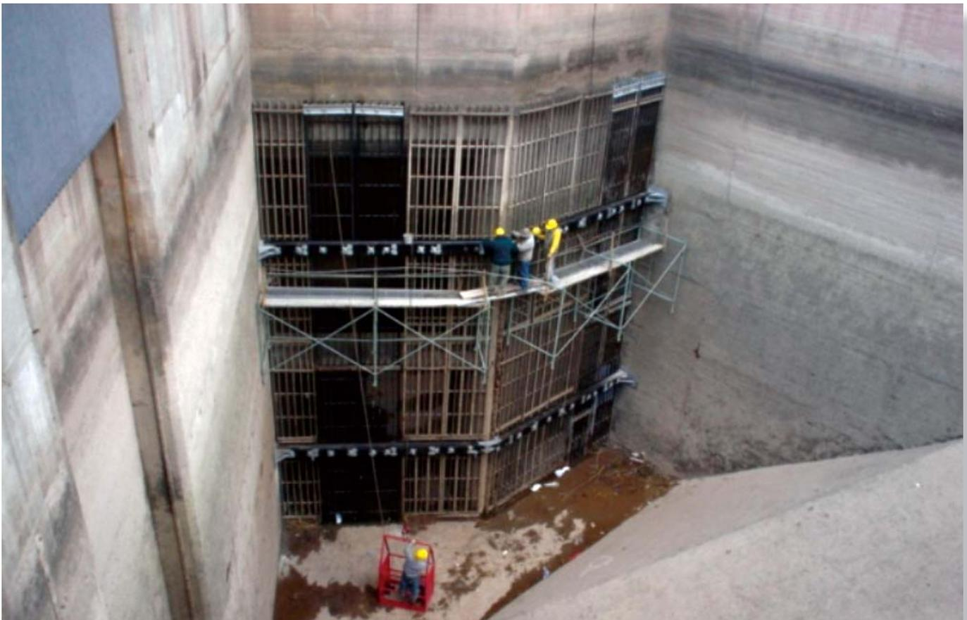
Vista de la toma de la conducción a la central con sus rejas. Nótese a la izquierda la compuerta de cierre para uno de los descargadores de fondo (Gentileza HINISA).
