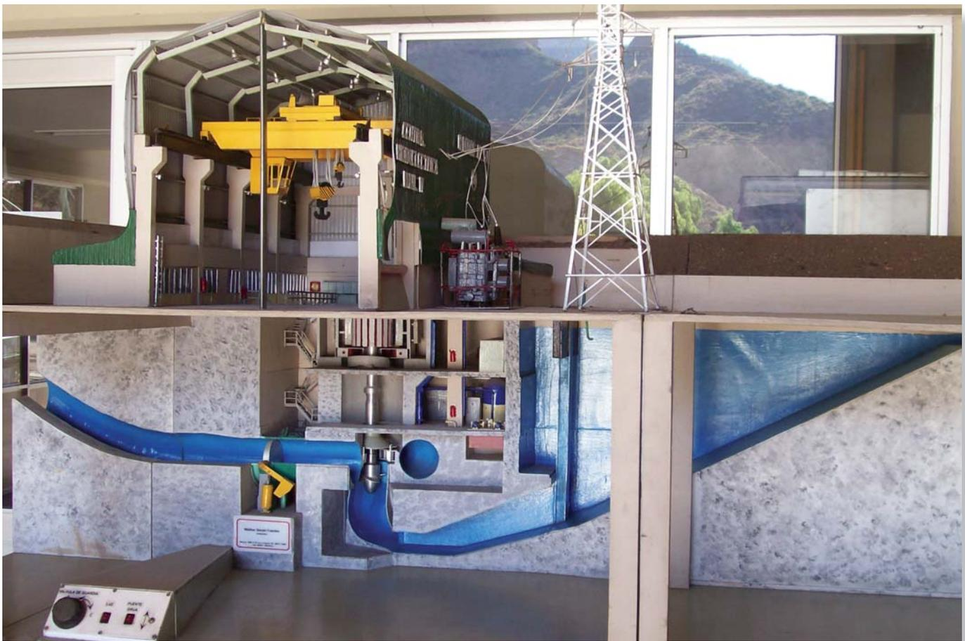
Vista de la maqueta del complejo. Puede apreciarse la válvula mariposa, la cámara espiral, la turbina y la estructura de las compuertas de restitución al río Atuel.
