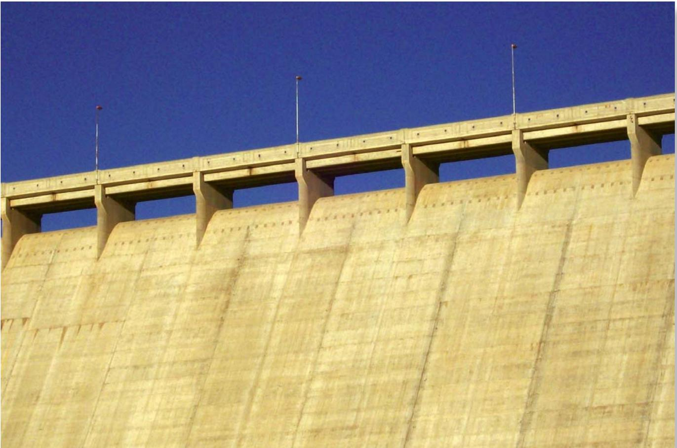
Vista de detalle de los vanos del vertedero. Puede apreciarse el perfil del umbral del vertedero y el puente vehícular sobre el mismo.
