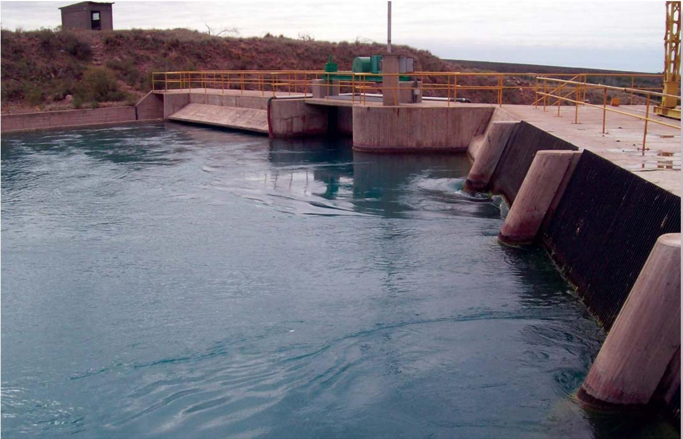
Vista de la cámara de carga, se puede ver desde izquierda a derecha; el vertedero lateral, el sifón de descarga, el compartimiento con sus accionamientos del descargador de sólidos y las rejas previas a los tres conductos.
