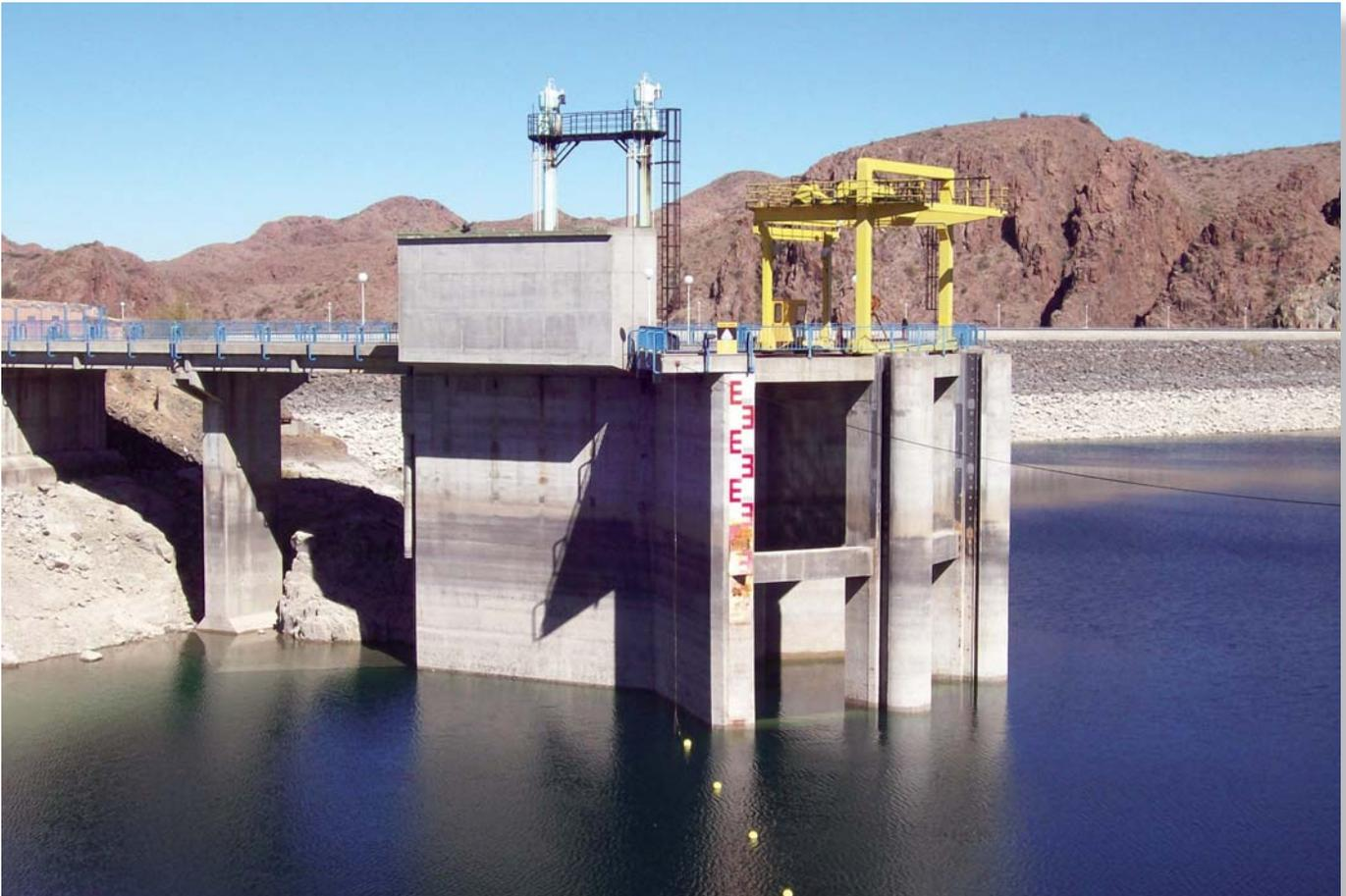
Vista de la toma de la central. Obsérvese las guías de las rejas con su pórtico de montaje, el sistema de apertura y el cierre hidráulico de la compuerta de servicio.
