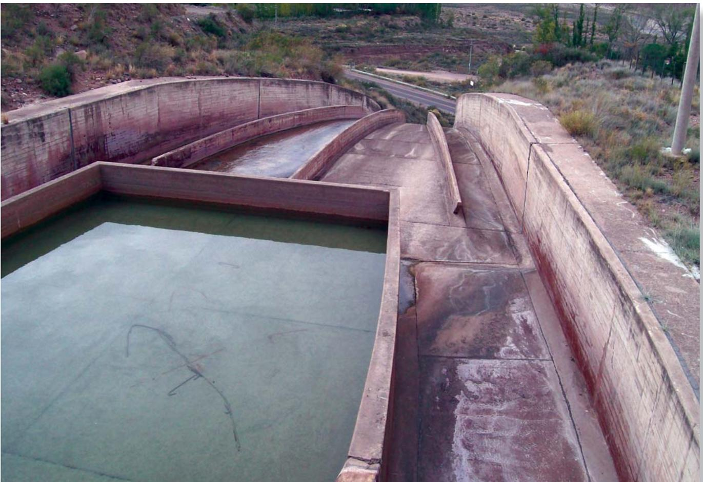
Vista del cuenco dissipador del sifón de descarga y de los canales de descarga de aliviadero lateral y descargador de materiales sólidos. Se observan los encauzadores del flujo en el canal de fuga.
