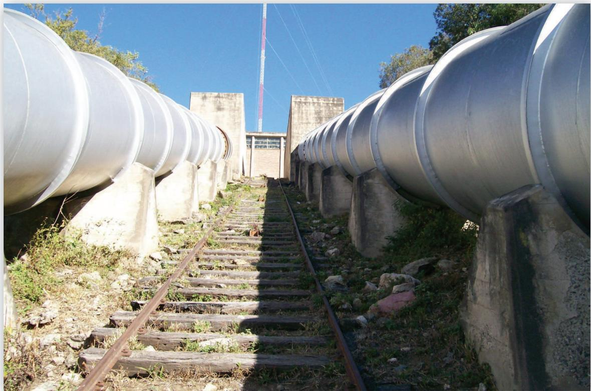
Vista de las tuberías forzadas a central luego de la casilla de válvulas que se aprecia al fondo.
