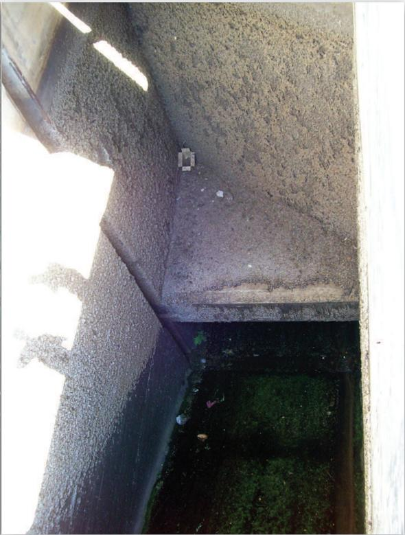
Vista de la restitución de la central al río Los Molinos. Nótese la marca del nivel líquido y las incrustaciones en los muros.
