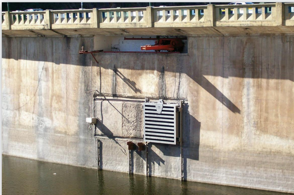
Vista en detalle del sistema de izaje de los elementos de cierre y una de las rejillas de los descargadores de medio fondo.
