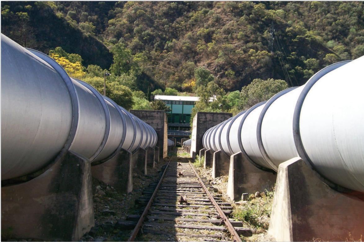
Vista de las tuberías forzadas bajando hacia el edificio de la central. Se pueden apreciar los macizos de hormigón dónde se apoya.
