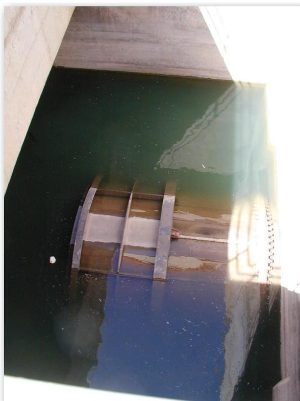
Vista de una de las dos válvulas de chorro hueco de la derivación para riego (Gentileza ENTE Ejecutivo Presa Embalse Casa de Piedra).
