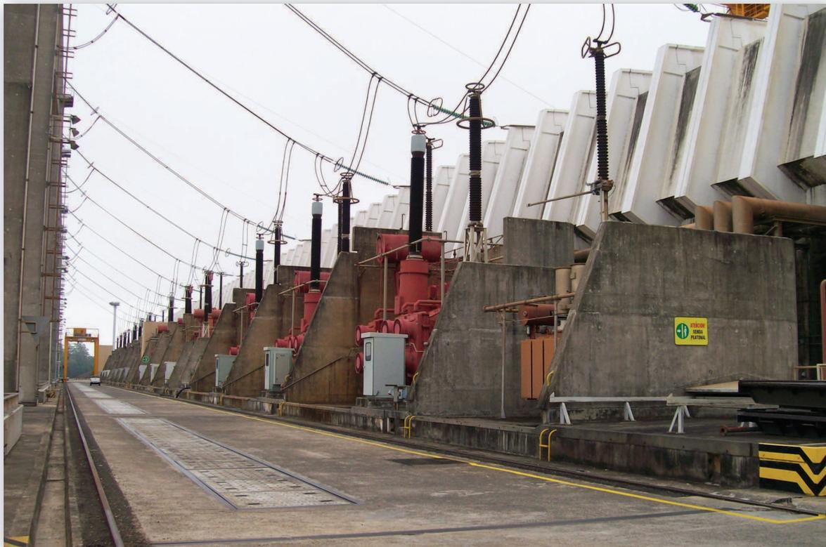
Vista de los transformadores de margen derecha. Nótese el puente grúa al fondo y en el piso, las tapas metálicas para colocar las ataguías de restitución al río.
