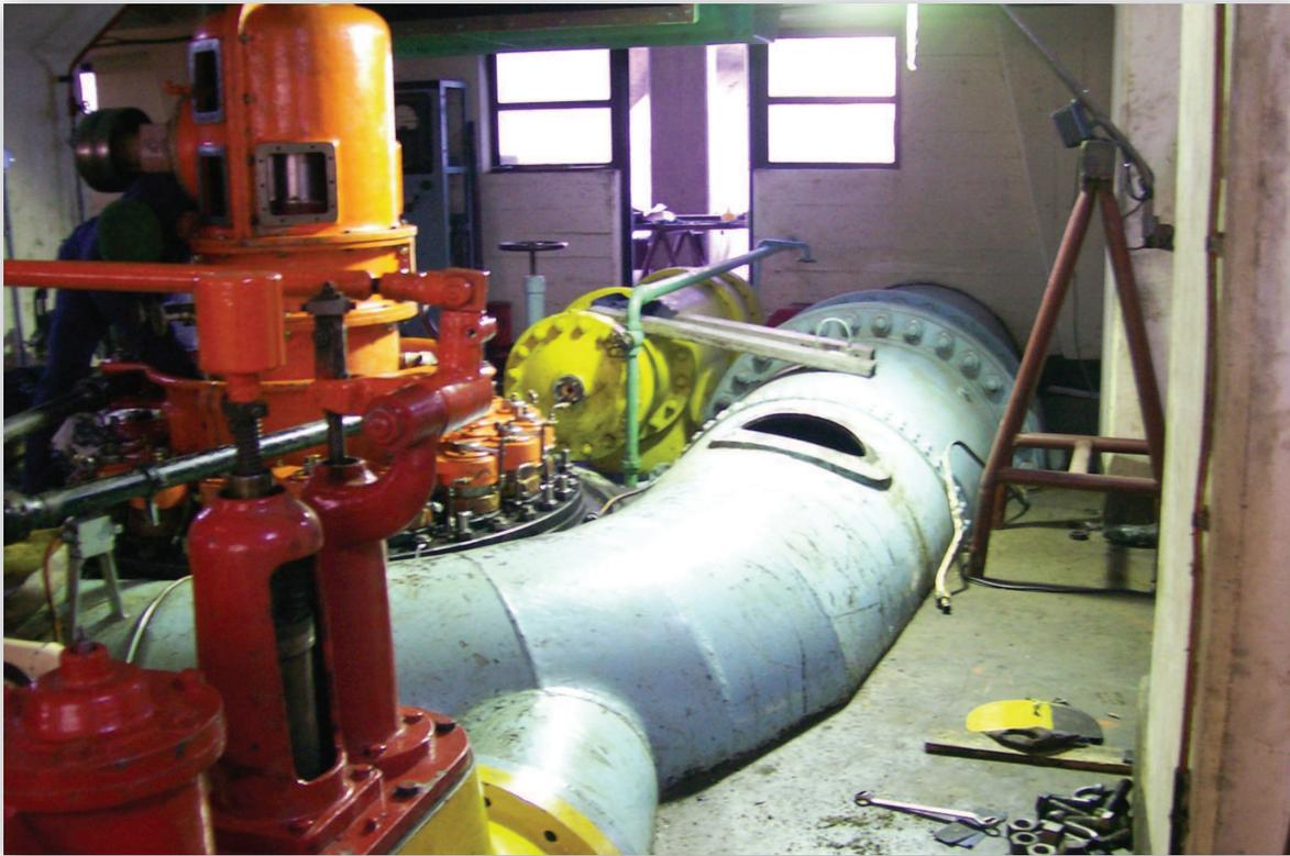
Vista de la cámara espiral de la turbina. Al fondo se aprecia la válvula mariposa de cierre en mantenimiento.
