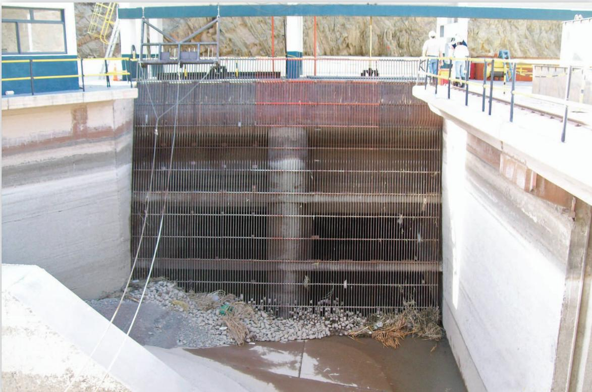
Vista de la toma a central en el azud derivador. Nótese las rejas y el edificio de comando a la izquierda (Gentileza AES Argentina Generación S. A.).
