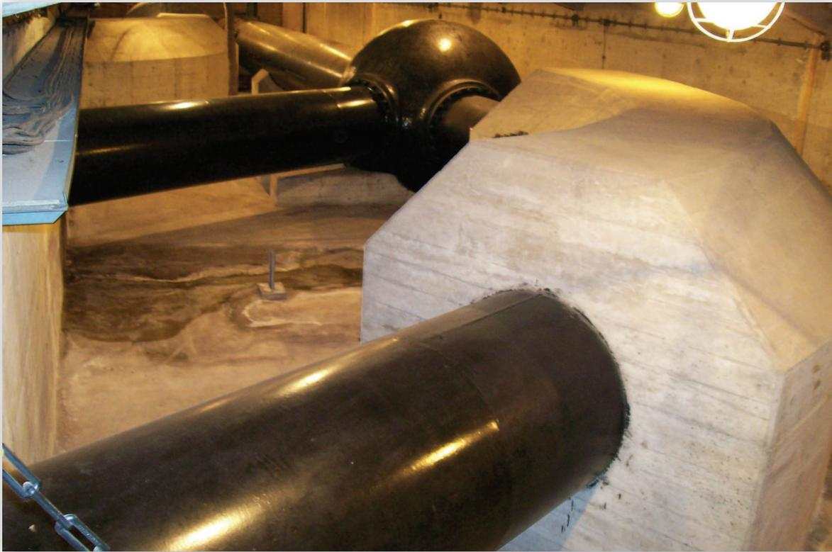
Vista de la bifurcación de una de las tuberías a dos de las turbinas. Nótese la derivación esférica y la curva empotrada en un dado de hormigón (a la derecha de la imagen).
