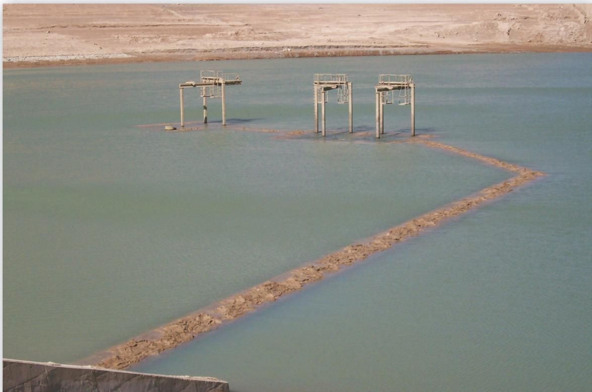
Vista de los pórticos para accionamiento de las compuertas en las tomas para el descargador de fondo (a la izquierda) y de conducción a central y riego (los de la derecha).
