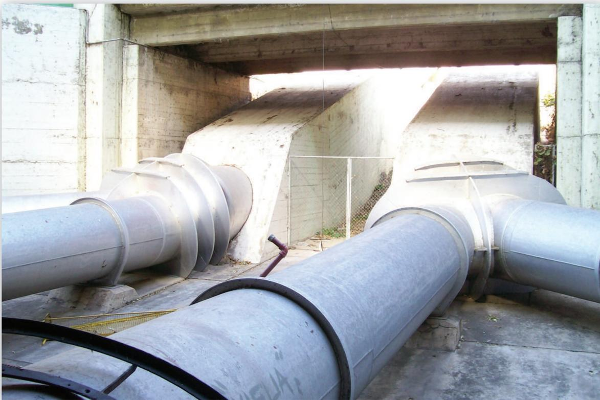
Vista de las derivaciones de cada conducción forzada, a las turbinas de la central.
