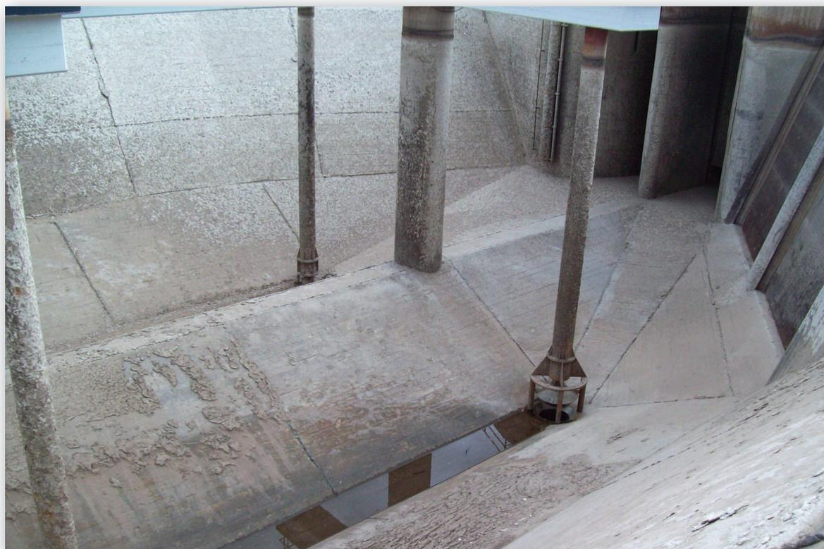
Vista de la cámara de carga dónde se aprecian las válvulas para la limpieza, arriba a la izquierda la toma para el vaciado y a su lado las rejas de la toma a central (Gentileza AES Argentina Generación S. A.).
