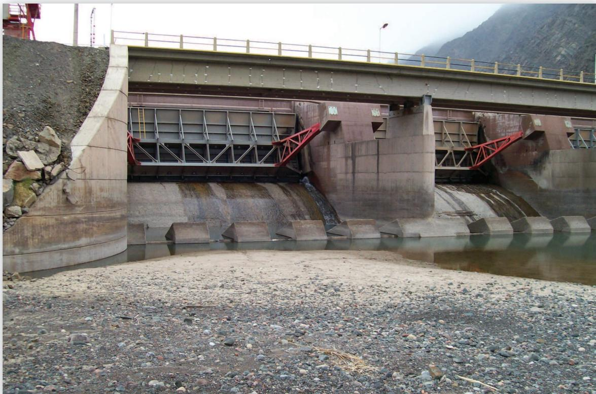
Vista de dos de los seis vanos del aliviadero, donde se aprecia la compuerta de sector, la curva de salida y los disipadores de energía.
