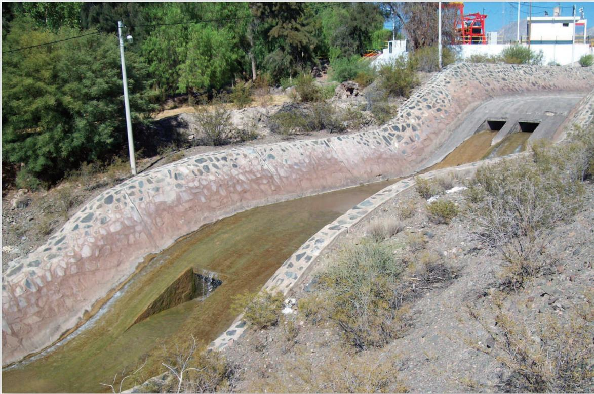
Vista de las salidas de las conducciones para el vaciado (arriba) y para la limpieza de la cámara de carga (abajo) (Gentileza AES Argentina Generación S. A.).
