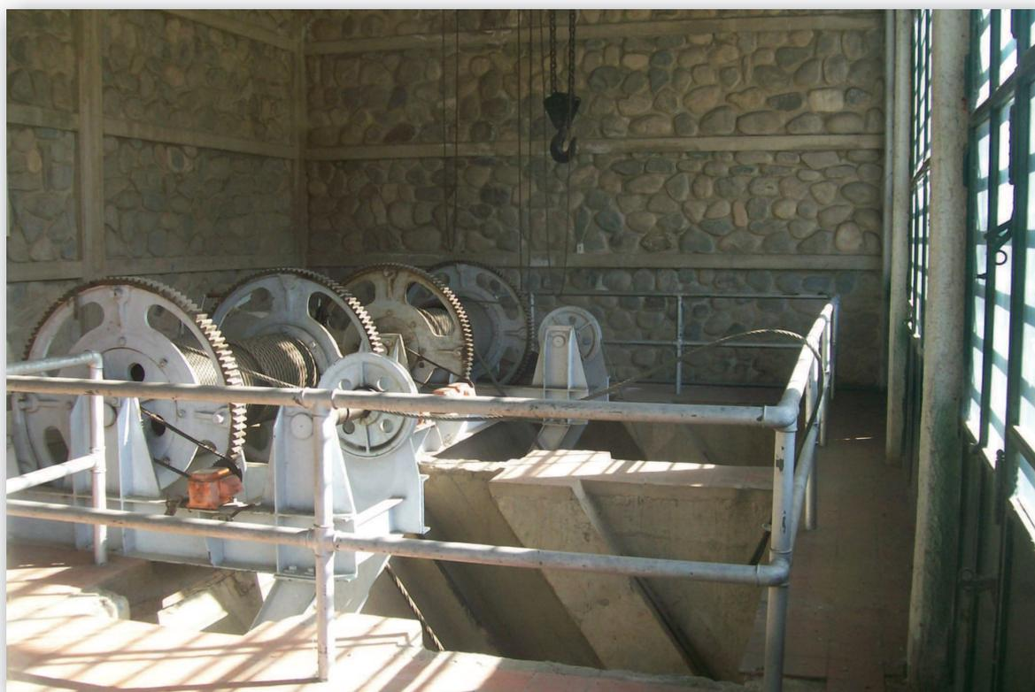
Vista del interior de la casa de maniobras. Se aprecian los mecanismos de izaje y las guías de deslizamiento de las compuertas.
