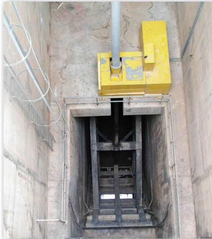
Vista de la compuerta sector del descargador de fondo.
