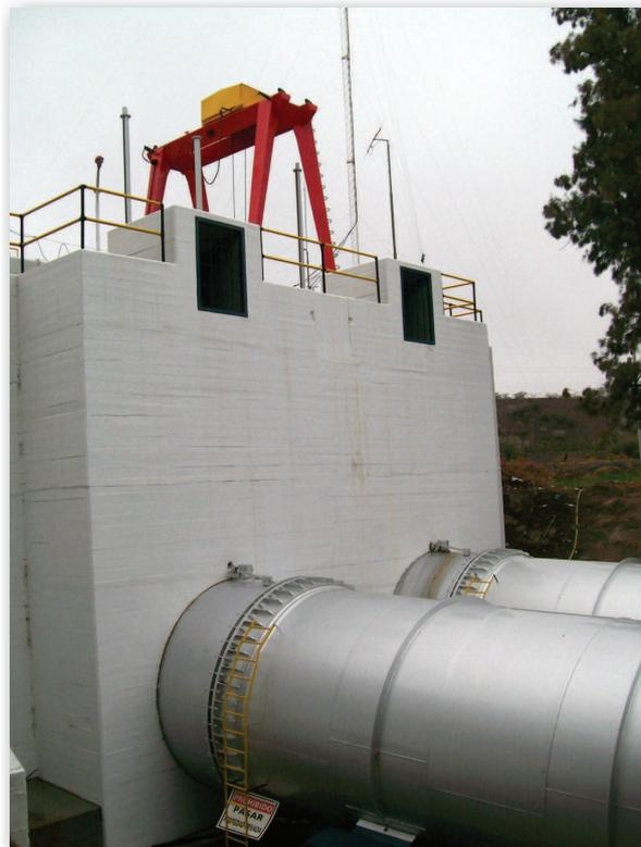
Vista del macizo de embocadura y el inicio de las tuberías metálicas sobre superficie. Sobre ellos se aprecian las salidas de los conductos dónde se expulsa el agua proveniente de la onda de presión al cerrar las válvulas.
