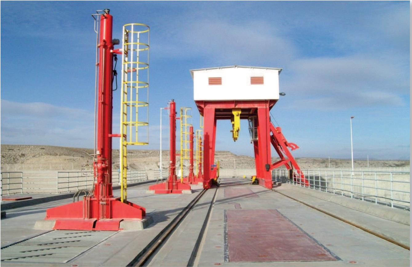
Vista de los accionamientos hidráulicos para las compuertas y del pórtico grúa para la colocación de las ataguías bajo las placas marcadas en color rojo en el piso.
