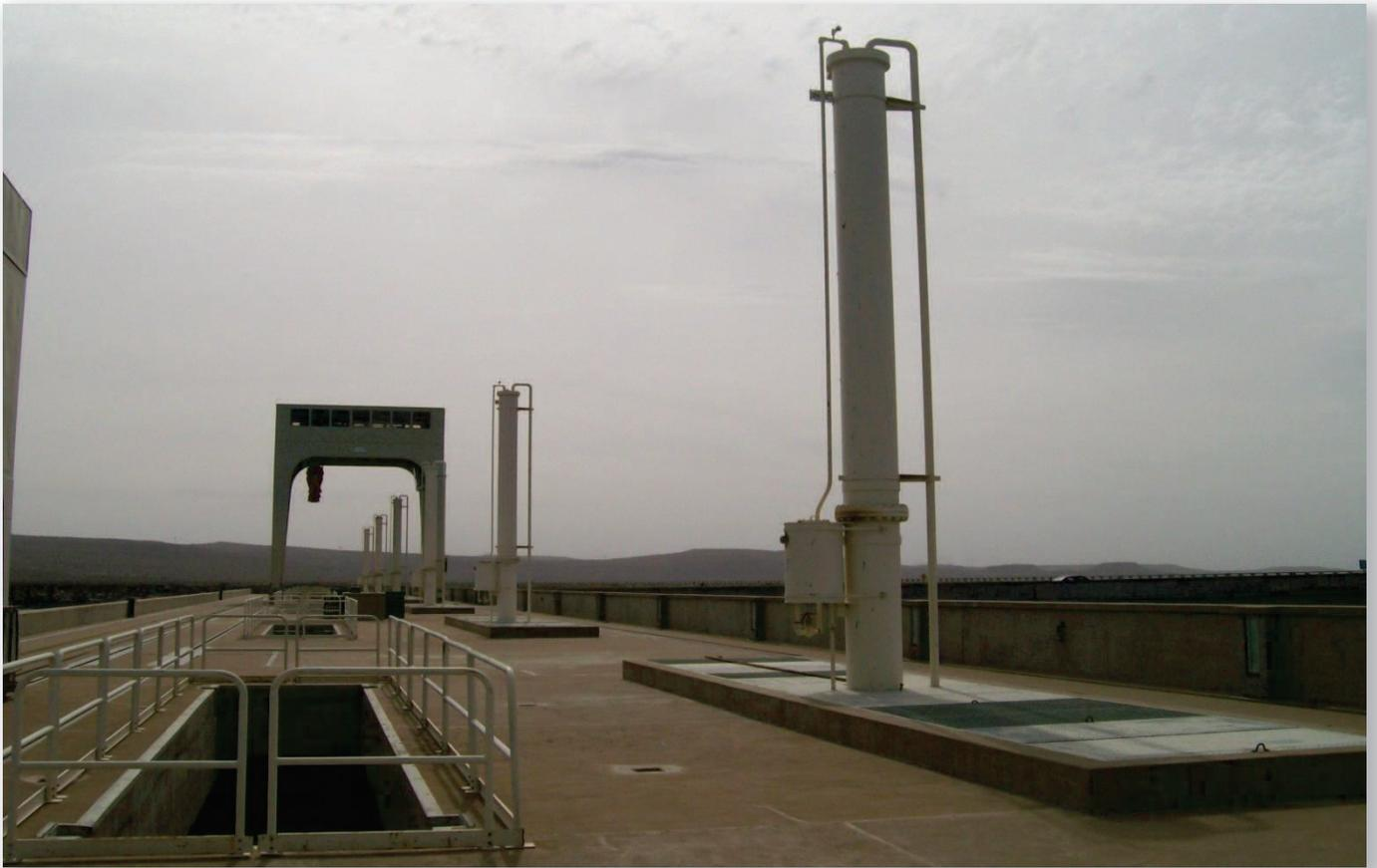
Vista de la obra de toma. A la derecha se aprecian los accionamientos de las compuertas de servicio y a la izquierda las aberturas para colocar las compuertas de mantenimiento.
