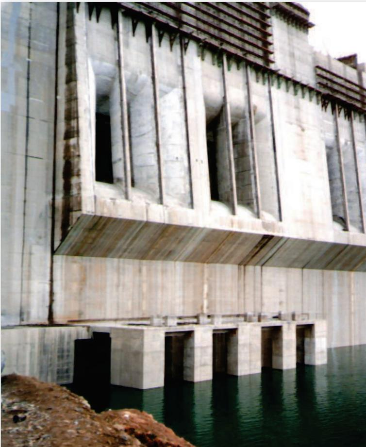
Vista de las tomas de la conducción a central. Nótese las guías para las rejillas. Gentileza Hidroeléctrica Piedra del Aguila S.A.
