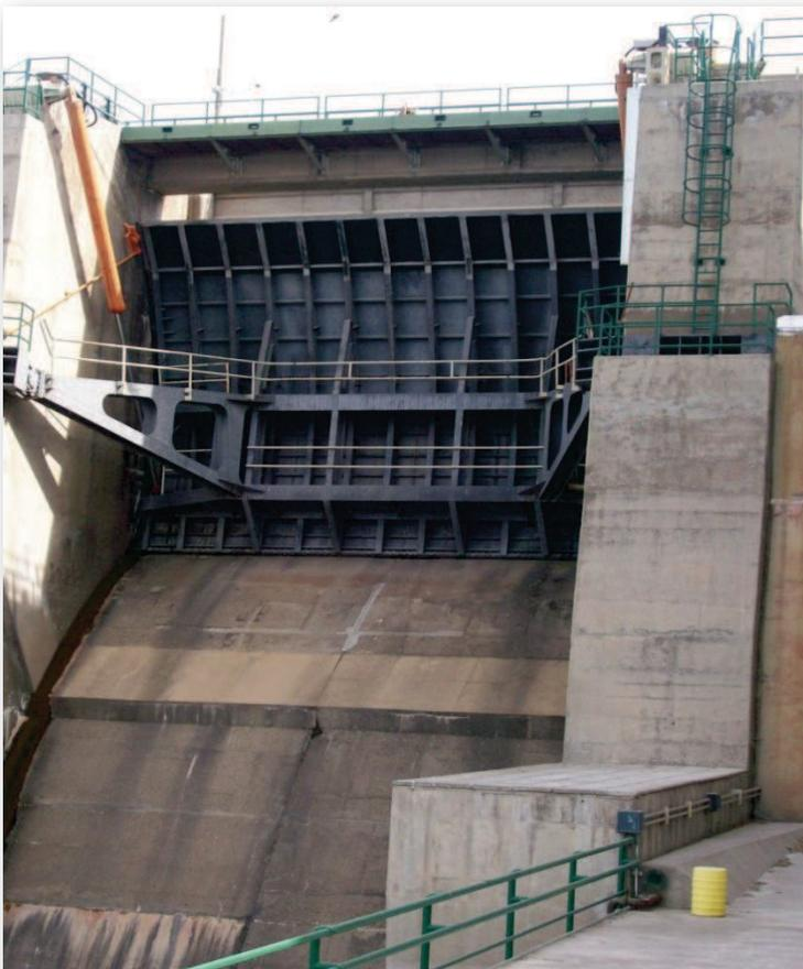
Vista en detalle de una de las siete compuertas de sector. Puede notarse el segmento agregado en la parte superior y el escalón para aireación.
