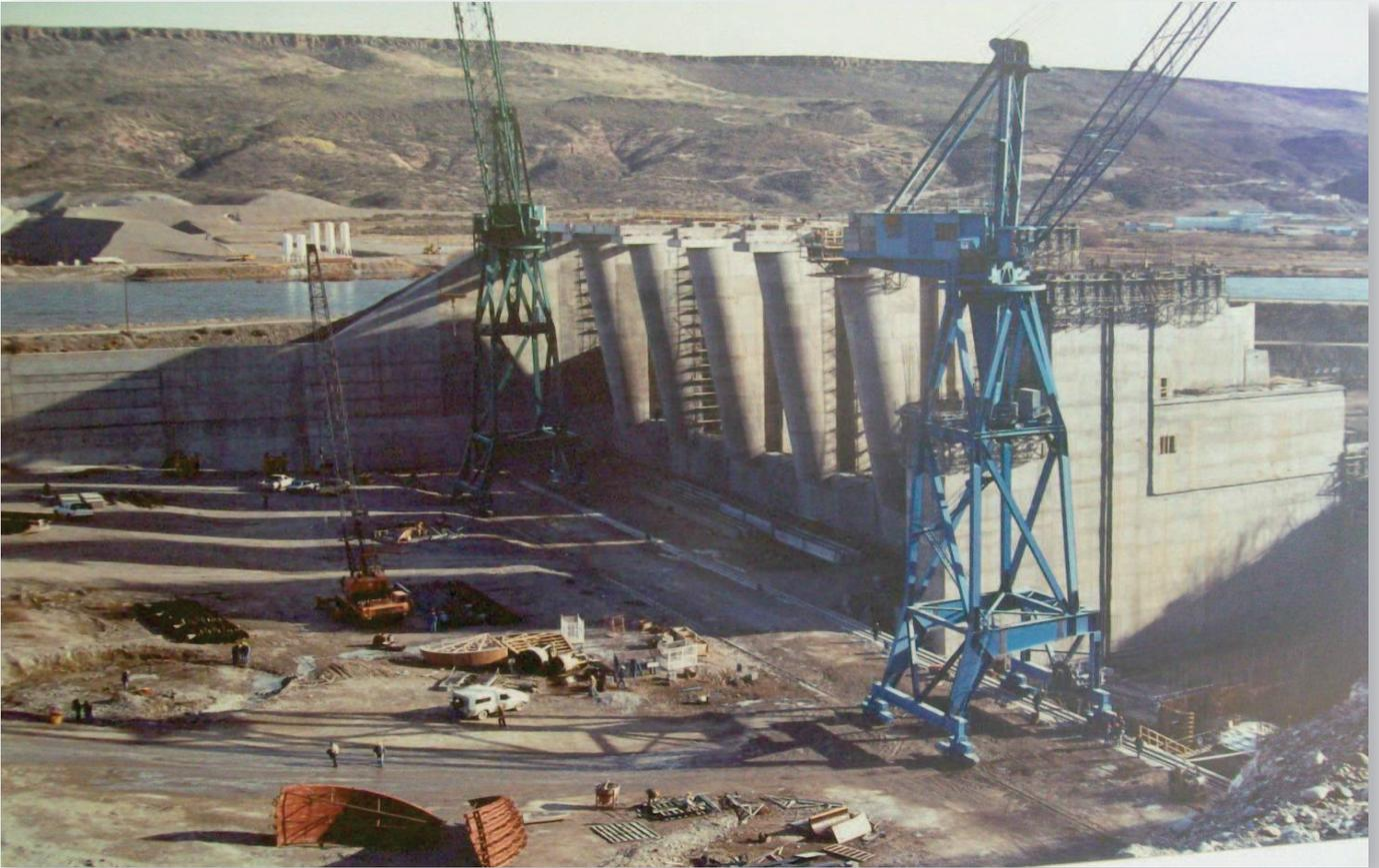
Vista de la toma del vertedero durante su construcción, se pueden ver las pilas del puente.
