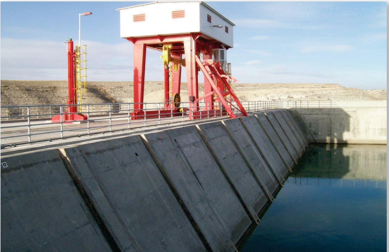
Vista de la toma a central en la dársena. Nótese uno de los accionamientos hidráulicos para las compuertas y el pórtico para la instalación de las rejillas.
