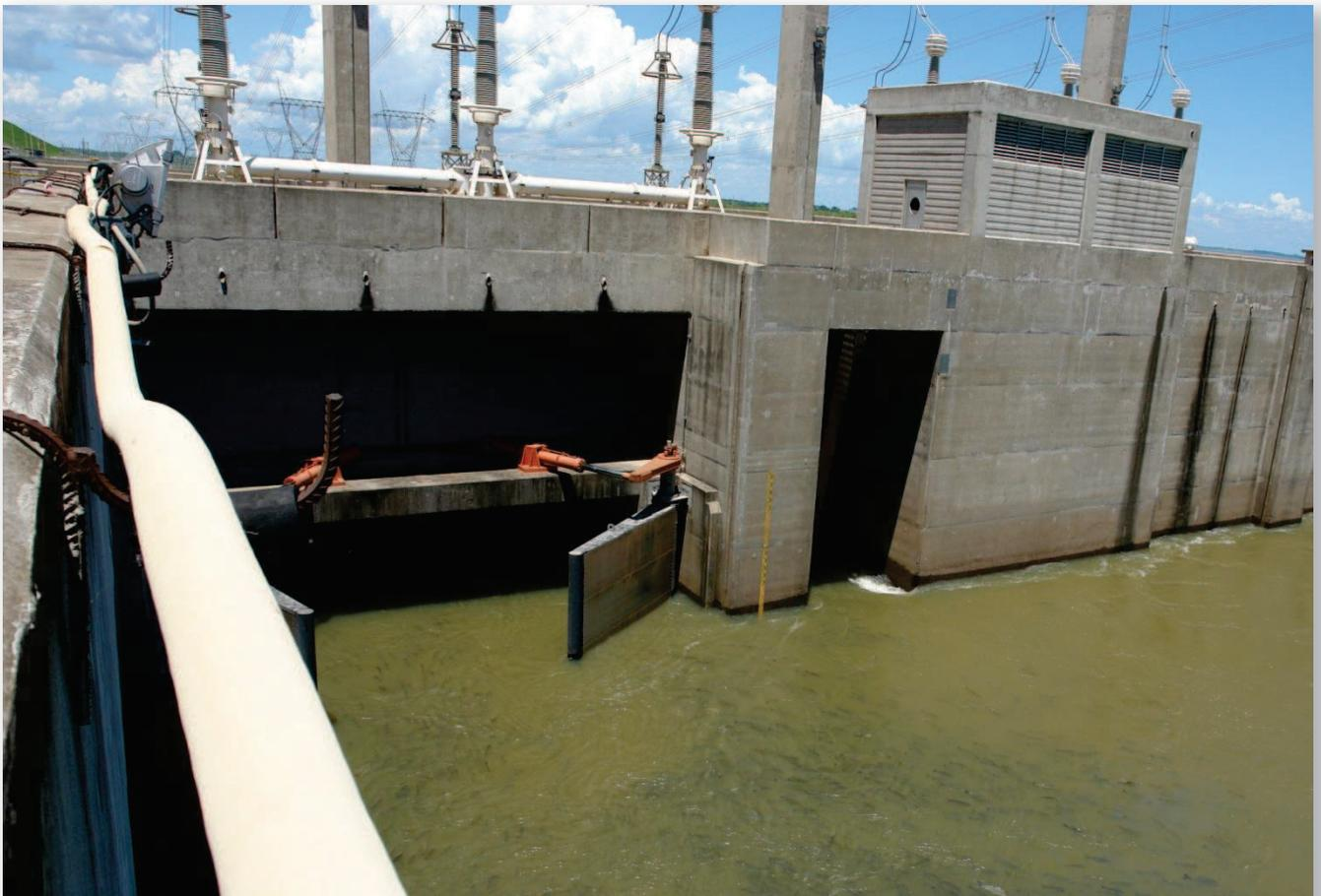
A la izquierda se observa el mecanismo de transferencia de peces. Gentileza E.B.Y.
