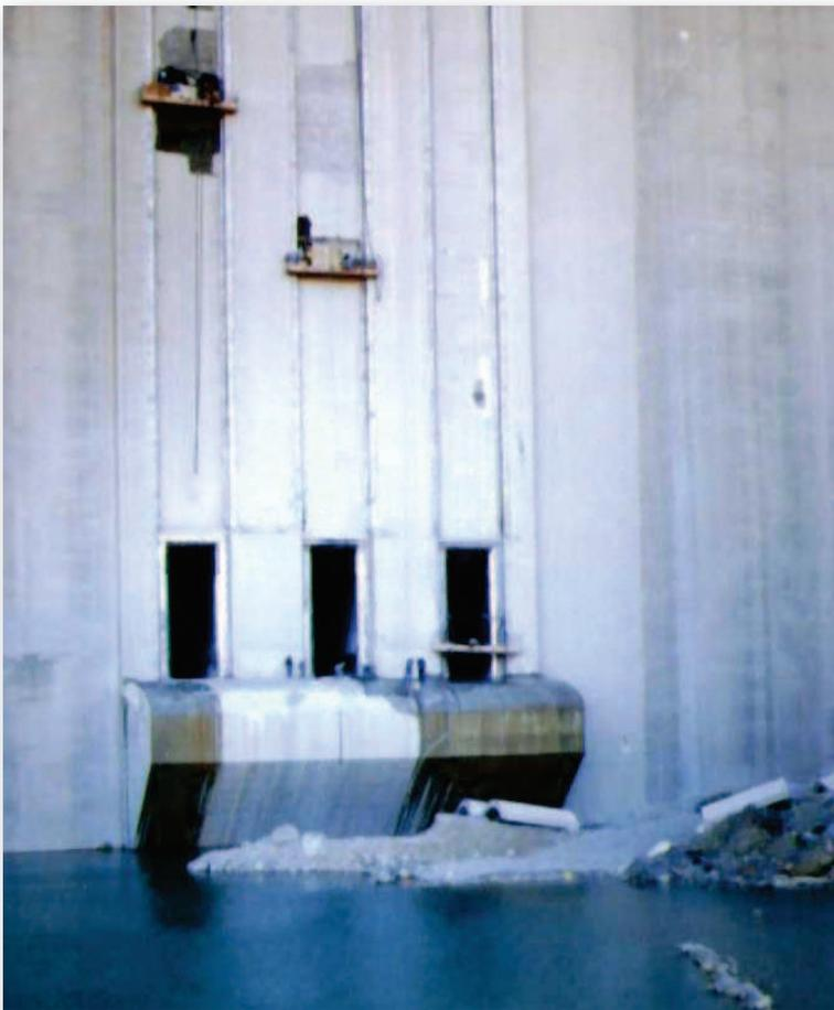
Vista de las tomas del descargador de fondo. Nótese las guías para los elementos de cierre y el tamaño respecto al personal allí ubicado. Gentileza Hidroeléctrica Piedra del Águila S. A.
