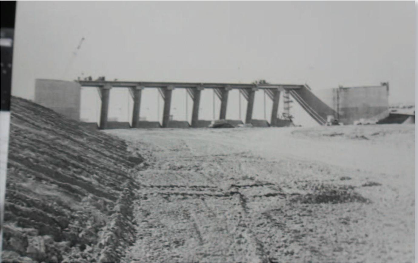
Vista durante la construcción desde aguas abajo del aliviadero de la presa El Chañar. Se pueden notar sus ocho vanos y parte del canal de descara al río Neuquén. Gentileza Duke Energy Cerros Colorados S. A.
