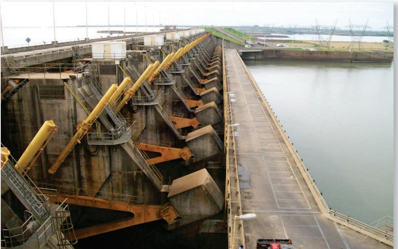
Vista del aliviadero del brazo principal, se observan los apoyos de los brazos de las compuertas con el accionamiento hidráulico de cada compuerta.
