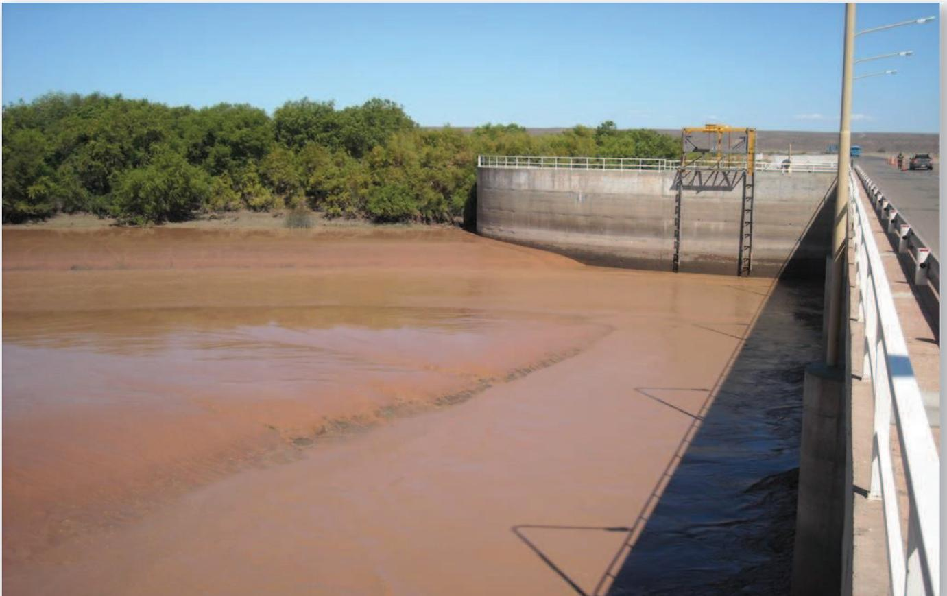
Vista de la margen izquierda del aliviadero, al fondo se aprecia el sistema de limpieza de las rejas para la descarga de riego del dique Portezuelo Grande. Gentileza Duke Energy Cerros Colorados S. A.
