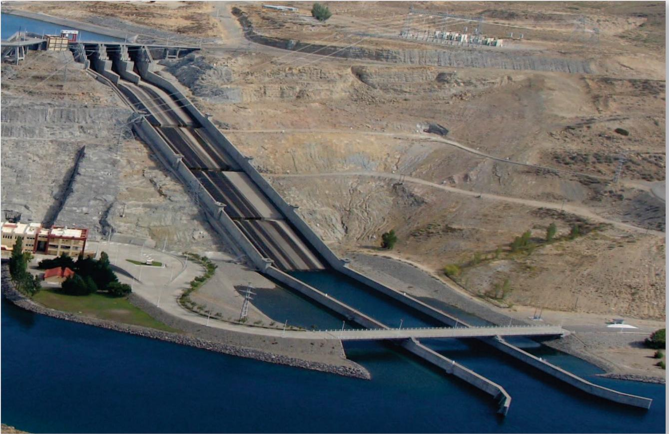
Vista general del aliviadero. Se aprecia el cuerpo del vertedero con sus tres compuertas, la rápida y el cuenco amortiguador.
