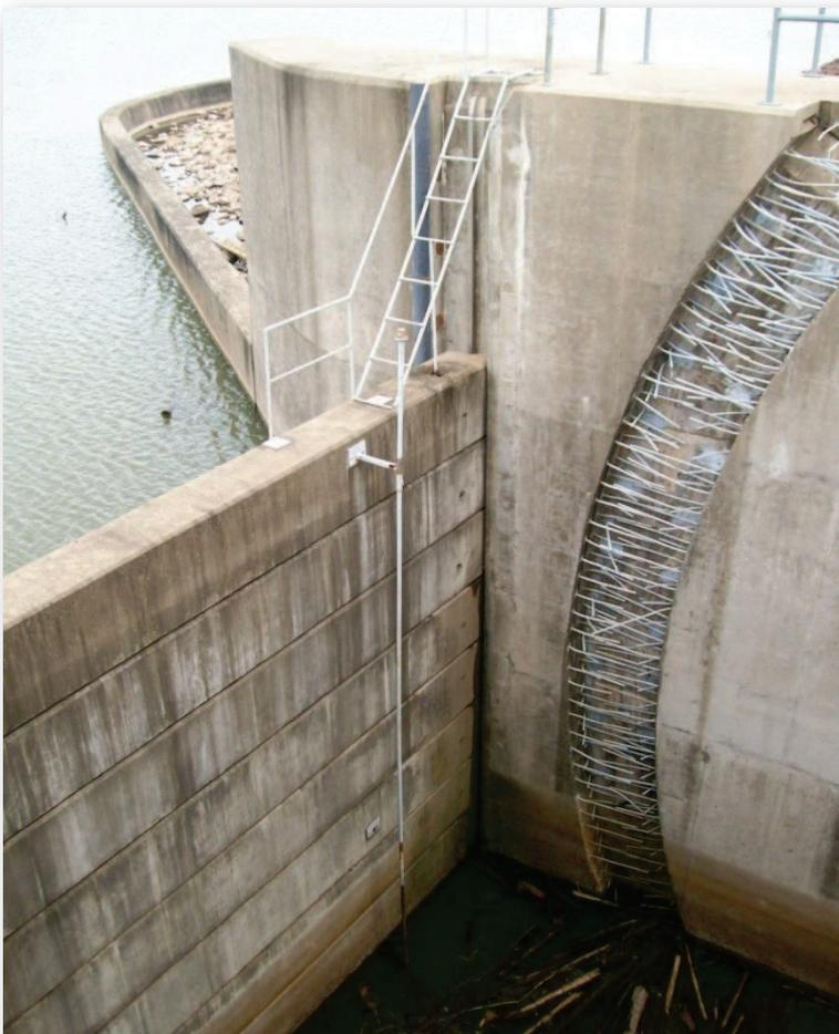
Vista de la toma para riego de la presa lateral derecha. Nótese el muro de encauzamiento a la entrada, el cierre provisorio con ataguías de hormigón y el espacio en los muros laterales para colocar las guías de las compuertas de sector.
