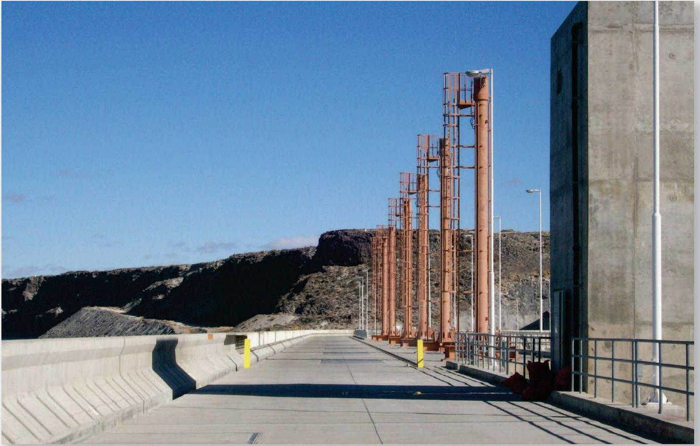
Vista de los accionamientos hidráulicos para las compuertas de las conducciones a central.
