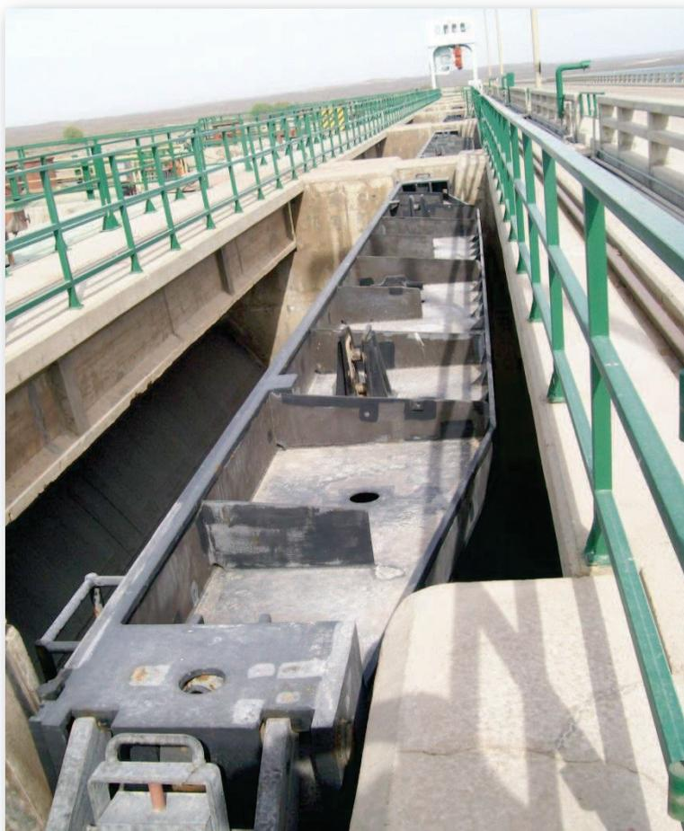
Vista de las una de las compuertas (que cumplen funciones de ataguías), para mantenimiento del aliviadero, al fondo se aprecia el puente grúa para su instalación.
