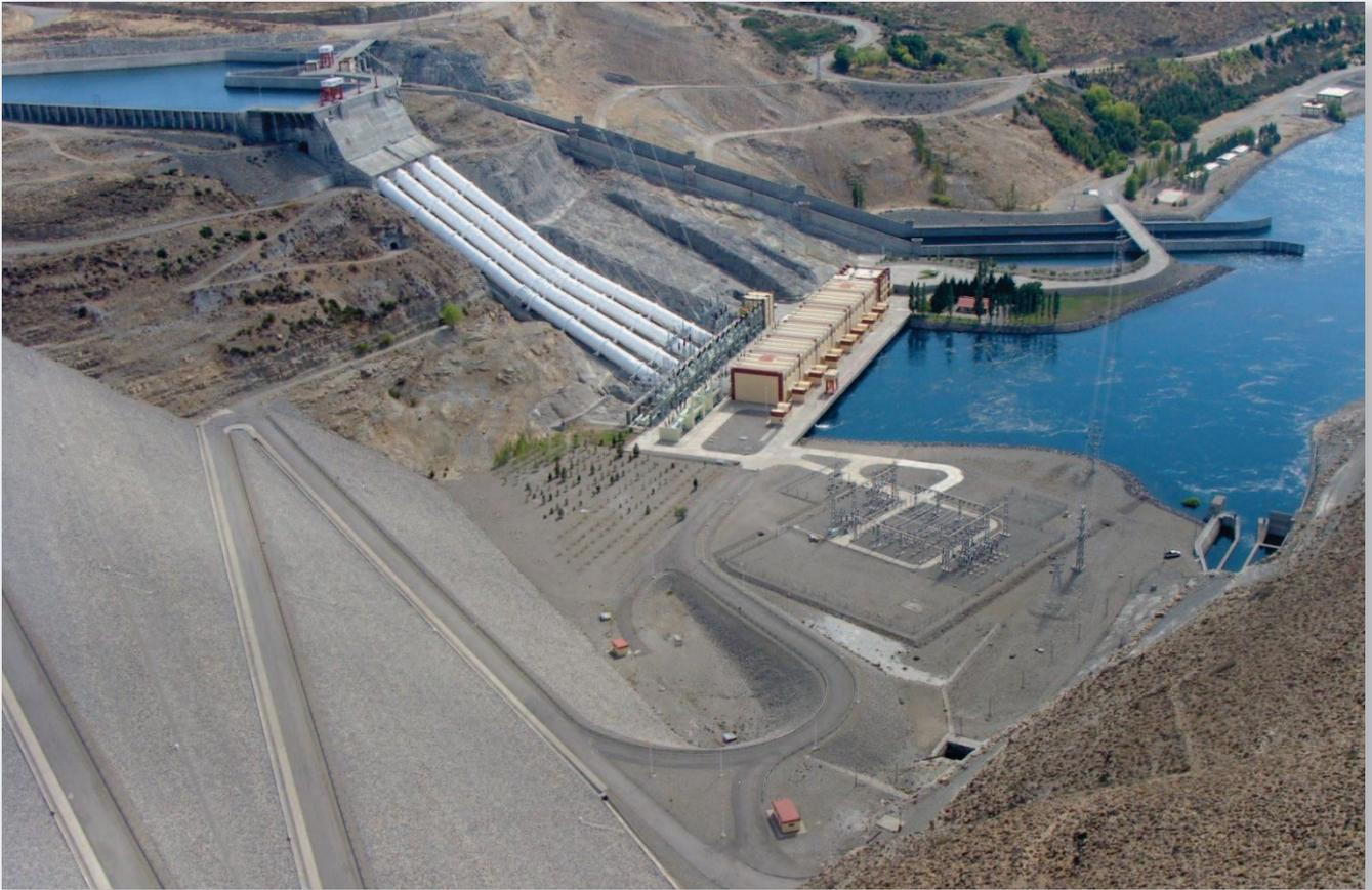
En ésta vista aérea puede apreciarse el talud aguas abajo de la presa, la dársena de aducción, las conducciones y la central. Al fondo se nota el aliviadero y a la derecha la salida del descargador de fondo. Gentileza Hidroeléctrica Alicurá S. A.
