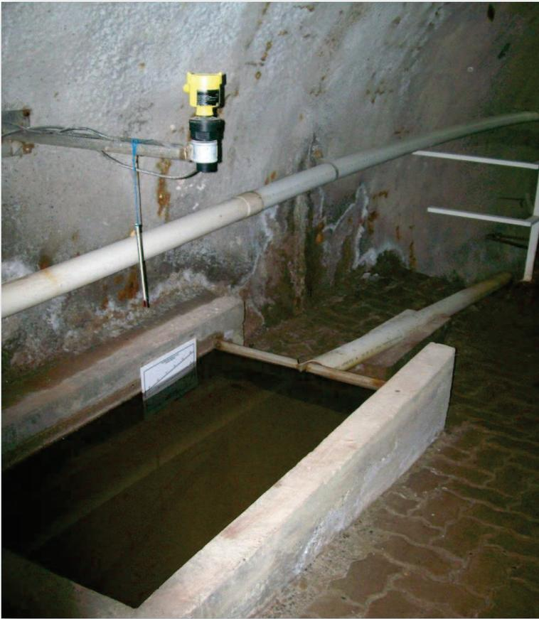
Vista del dispositivo para medir el nivel de agua en la pileta de recepción de agua producto de filtraciones aguas arriba del eje de la presa. Este se ubica en el túnel excavado con posterioridad a la construcción de la presa.
