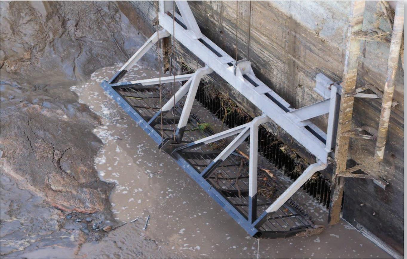
Vista en detalle del sistema de limpieza de las rejas para la descarga de riego del dique Portezuelo Grande. Gentileza Duke Energy Cerros Colorados S. A.
