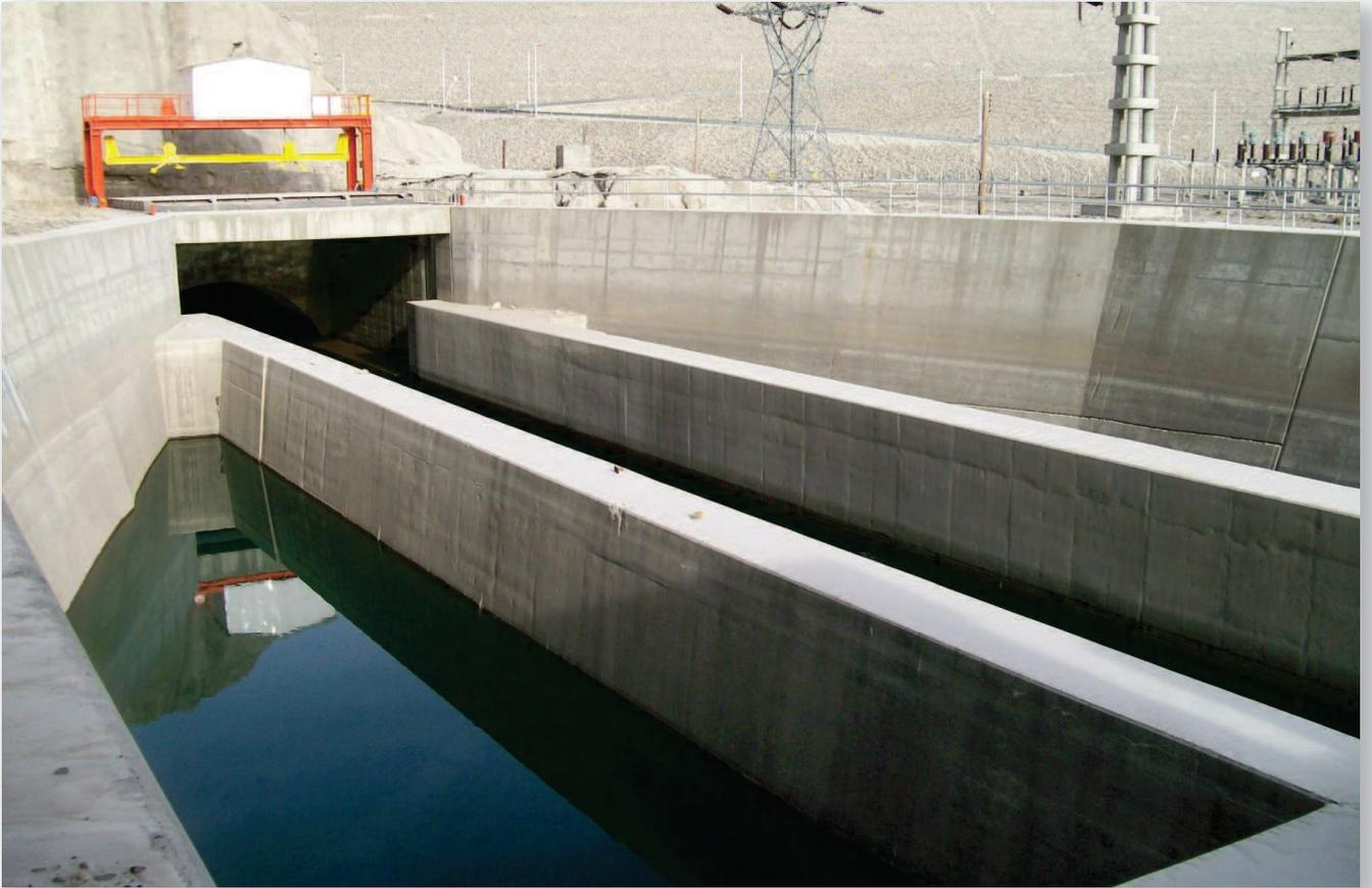
Vista de la salida del descargador de fondo, se puede apreciar la sección del conducto.
