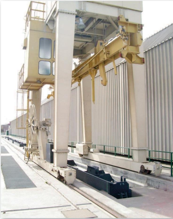
Vista de las compuertas de aguas arriba de la central con su puente grúa para su colocación. Al fondo se aprecia el edificio de la central.
