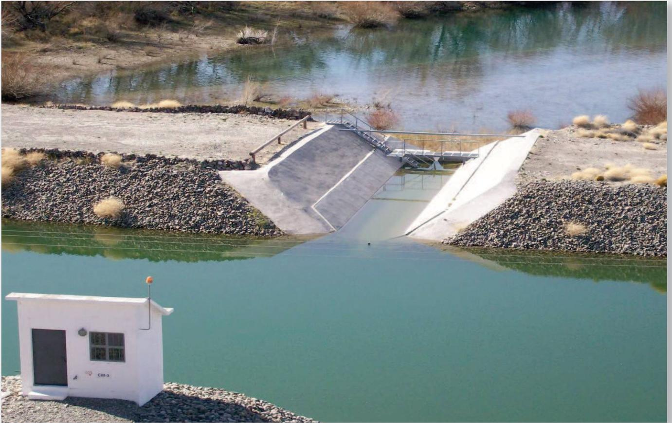
Vista del aforador (para medición de caudales) de filtraciones ubicado inmediatamente aguas abajo de la presa.
