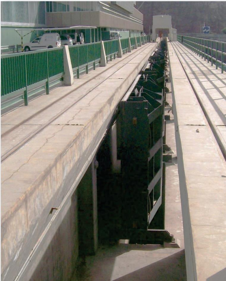
Vista de las compuertas de cierre de la restitución al río Limay de la central.
