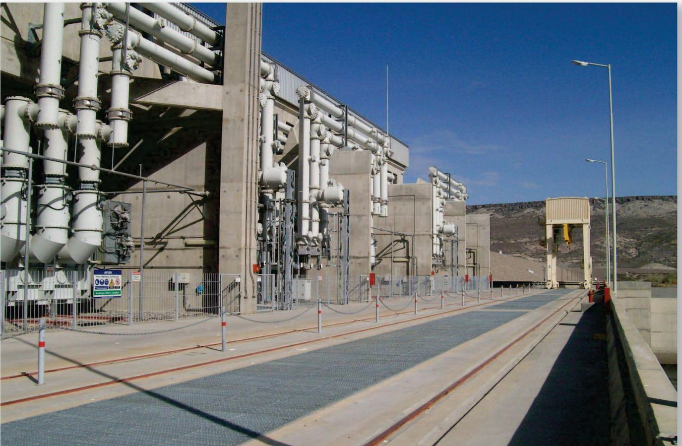
Vista del parque de transformadores de la central. Bajo las rejas en primer plano, se colocan las compuertas para mantenimiento (de restitución), mediante el puente grúa que se aprecia al fondo.
