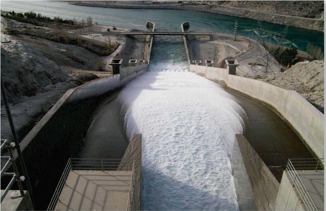
Vista de la rápida del aliviadero. Se aprecian las torres para aireación, los dados deflectores al final de la rápida y al fondo el cuenco amortiguador.
