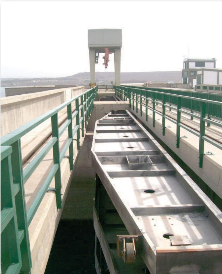
Vista de las compuertas planas de cierre y el puente grúa para su colocación y descenso.
