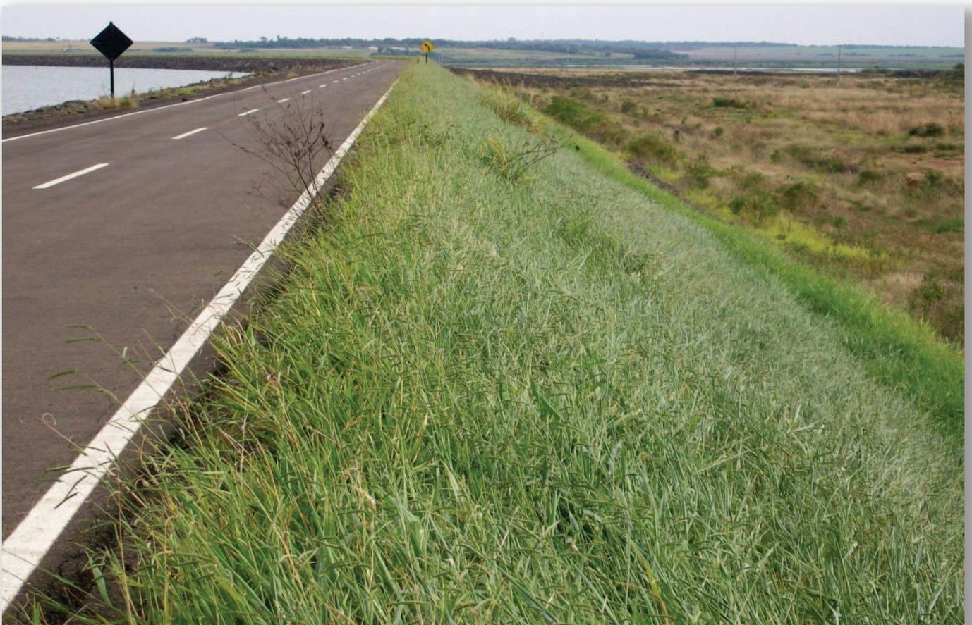
Vista del talud aguas abajo de la presa lateral derecha. Nótese la vegetación sobre el mismo.
