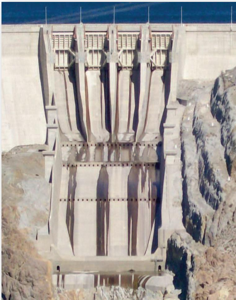
Vista del aliviadero donde se puede apreciar las compuertas, las torres de aireación, los tres escalones y el salto de esquí.
