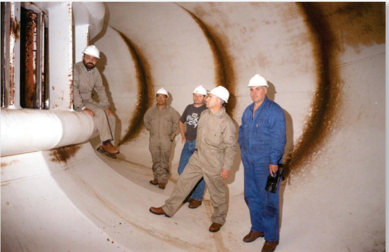
Vista del interior de la cámara espiral en mantenimiento. Nótese a la izquierda los distribuidores y pre-distribuidores de la turbina. Gentileza Hidroeléctrica Alicurá S. A.
