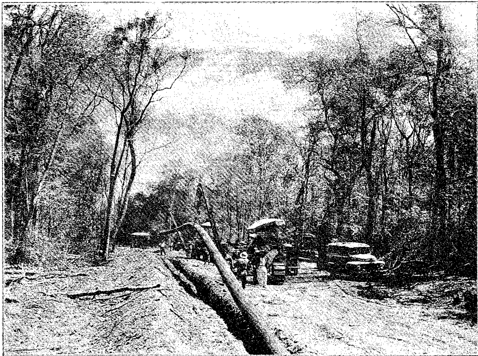
Tendido del Gasoducto del Norte
